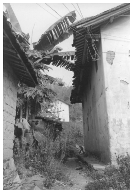
重庆楼和光裕楼之间的小巷。
